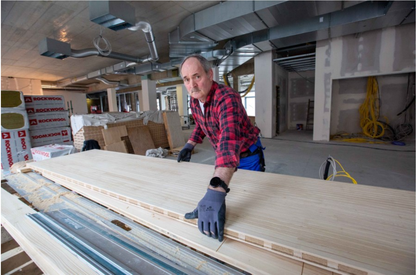
Trockenbauer Günter Erl von der Firma Ssyckor-Massivhaus-Bau aus Boxberg baut derzeit eine schalldämmende Akustikholzdecke in der neuen Bibliothek im Kamenzer Lessing-Gymnasium ein. Foto: Matthias Schumann
